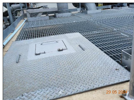
รูปที่ 2.9 ป่อตรวจสภาพน้ำ (Inspection Manhole)
