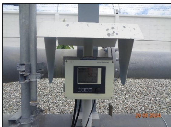
รูปที่ 2.12 ระบบตรวจสอบคุณภาพน้ำต่อเนื่อง (Online Monitoring)
