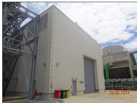
รูปที่ 2.5 อาคารครอบบริเวณเครื่องจักรที่มีเสียงดัง
