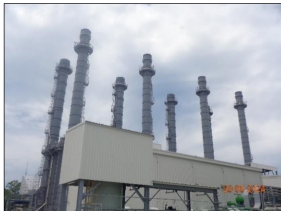
รูปที่ 2.1 ปล่องระบายจากหน่วยผลิตไอน้ำ (HRSG)
