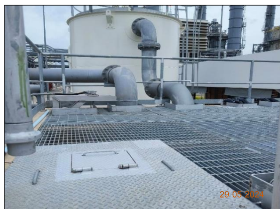
รูปที่ 2.9 ป่อตรวจสภาพน้ำ (Inspection Manhole)
