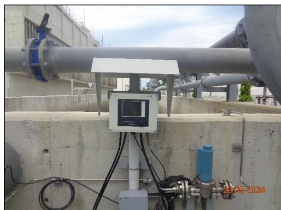
รูปที่ 2.12 ระบบตรวจสอบคุณภาพน้ำต่อเนื่อง (Online Monitoring)
