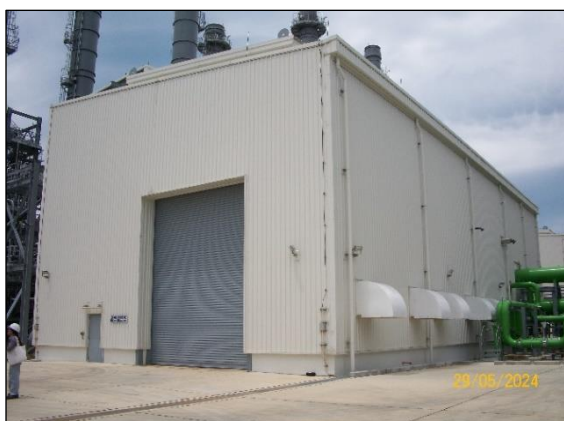
รูปที่ 2.5 อาคารครอบบริเวณเครื่องจักรที่มีเสียงดัง
