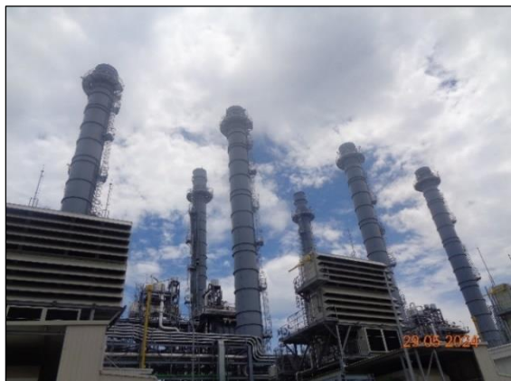
รูปที่ 2.1 ปล่องระบายจากหน่วยผลิตไอน้ำ (HRSG)
