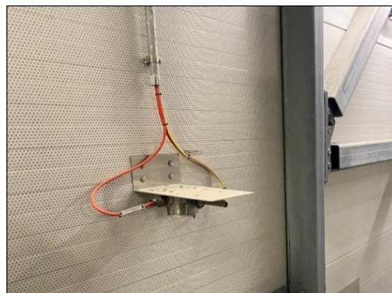
รูปที่ 2.34 การติดตั้ง Heat Detectors
