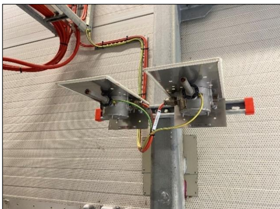
รูปที่ 2.34 การติดตั้ง Heat Detectors
