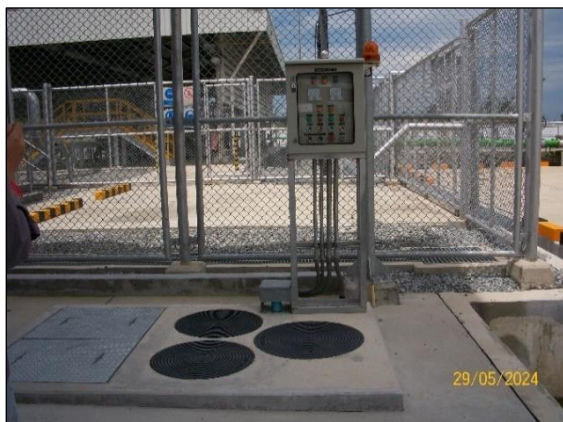
รูปที่ 2.13 ระบบบำบัดน้ำเสียสำเร็จรูป (Septic Tank)
